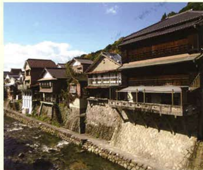
●真弓橋から見る川沿いの風景
