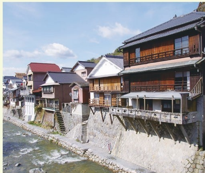
●真弓橋から見る川沿いの風景
